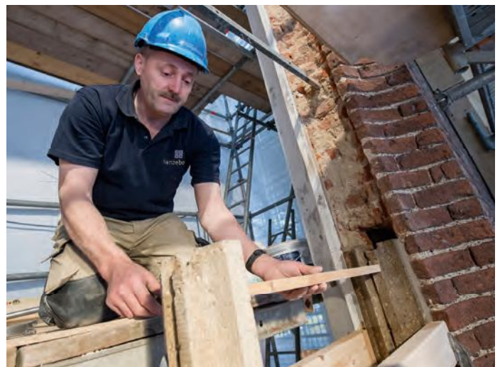
Maatlat voor vaste afstand middenmontant-zijmontant
