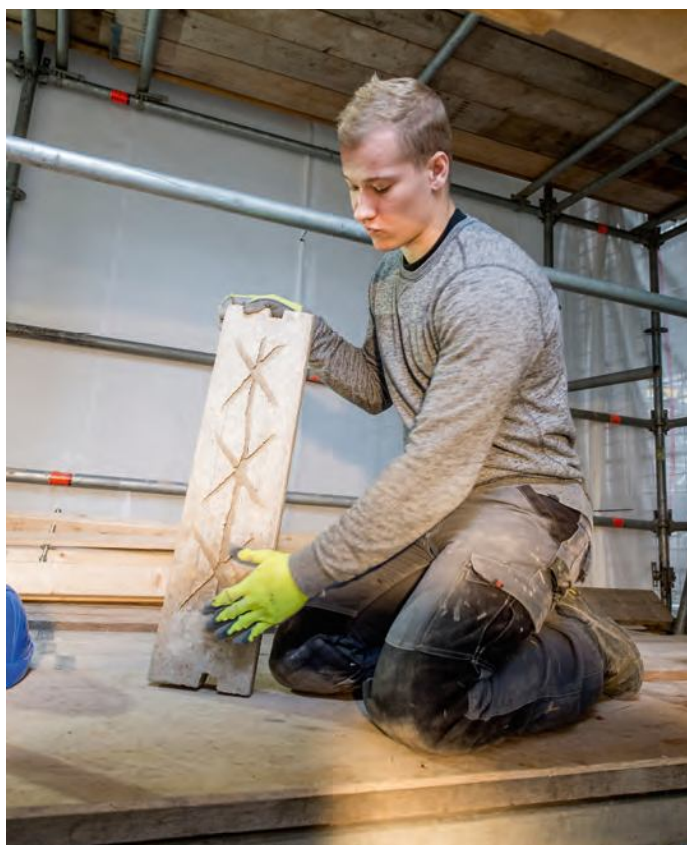
De achterzijde van zijmontant wordt opgeruwd voor betere hechting
