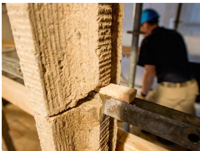
Tijdelijk vastgezet met wiggen tussen middenmontant en brugstaaf
